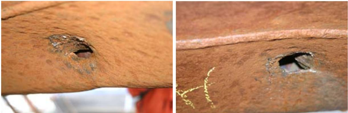
Abbildungen 21 und 22: Löcher ( $\varnothing$  ca. 4 cm bis 6 cm) in der Backbordkimm - Ballasttank 5 - 25.2.2011
