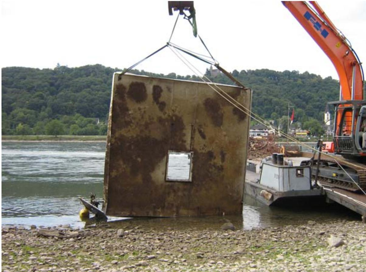
Abbildung 12: Bergung des (vermutlichen) Steuerhausdaches des TMS „Waldhof“ bei Rhein-km 575,6 am 29.8.2012
