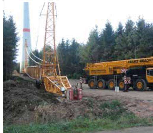
Abbildung: Kranmontage für den Bau eines Windrades im Wald; Quelle: Forstamt Kastellaun.
