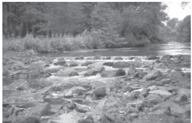
*Rückbau eines Wehres an der Ahr. Durch solche Maßnahmen wird die ökologische Durchgängigkeit gefördert.*
